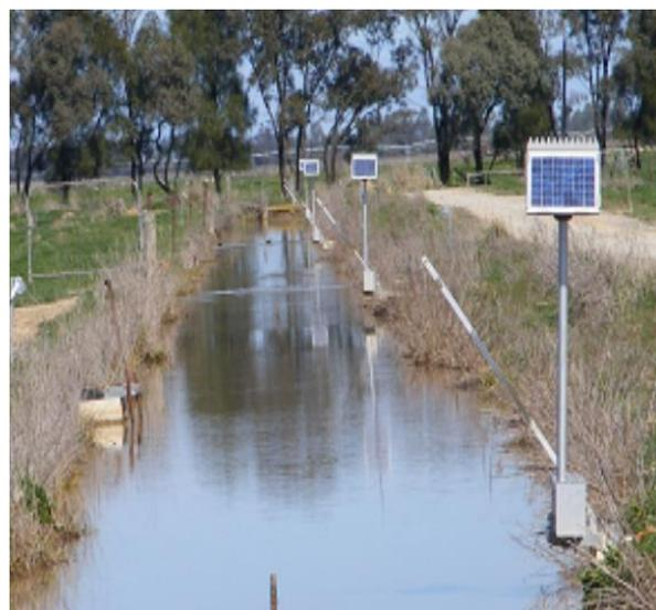
Se realizan riegos de gran volumen (100 mm) por corto tiempo (2 horas de riego en cada potrero). Antes para regar 100 mm se requerían de 6 horas, además de personal que recorra y se dedique a abrir y cerrar las compuertas. Actualmente se realiza en forma automática y en sólo 2 horas.
